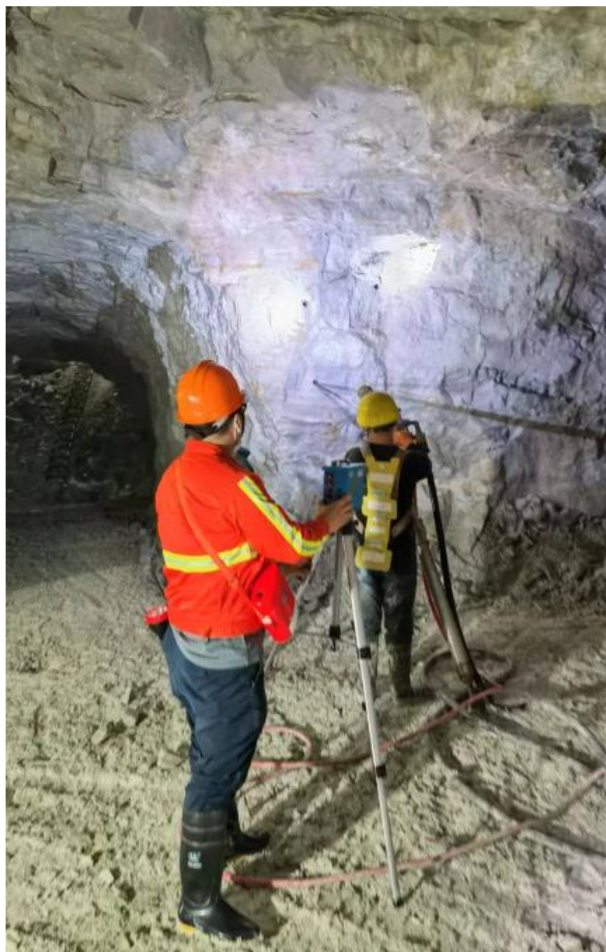
现场采样、检测
